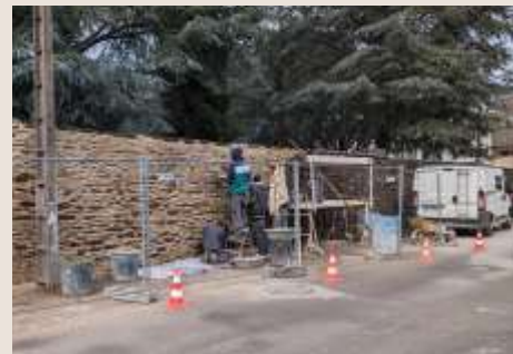
Chantier d'insertion Gros Œuvre à Rennes (35)
