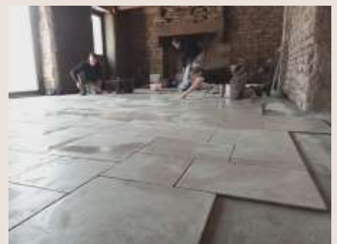
Chantier PO COB (56)
