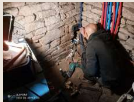
Chantier propriétaire occupant (29) sécurisation électrique
