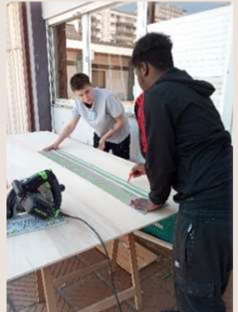
Rénovation d'un local associatif (35)
