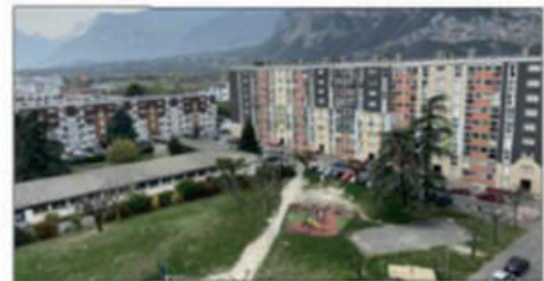
Les habitants de la Luire et de la Viscose peuvent désormais bénéficier d'un chantier ARA et apprendre à réaliser des travaux dans leur logement.
